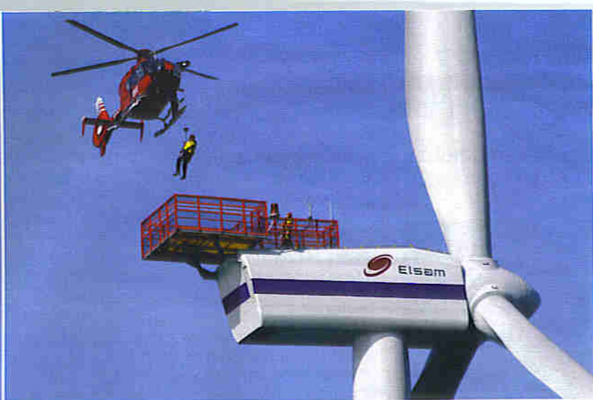
WARTUNG IM STURM Weil Reparaturen auf dem Meer besonders teuer und kompliziert sind, planen die Alpha-Ventus-Techniker auf Vorrat: Alle wichtigen Teile der Maschine wie Ölpumpe oder Kühlaggregate sind doppelt vorhanden
