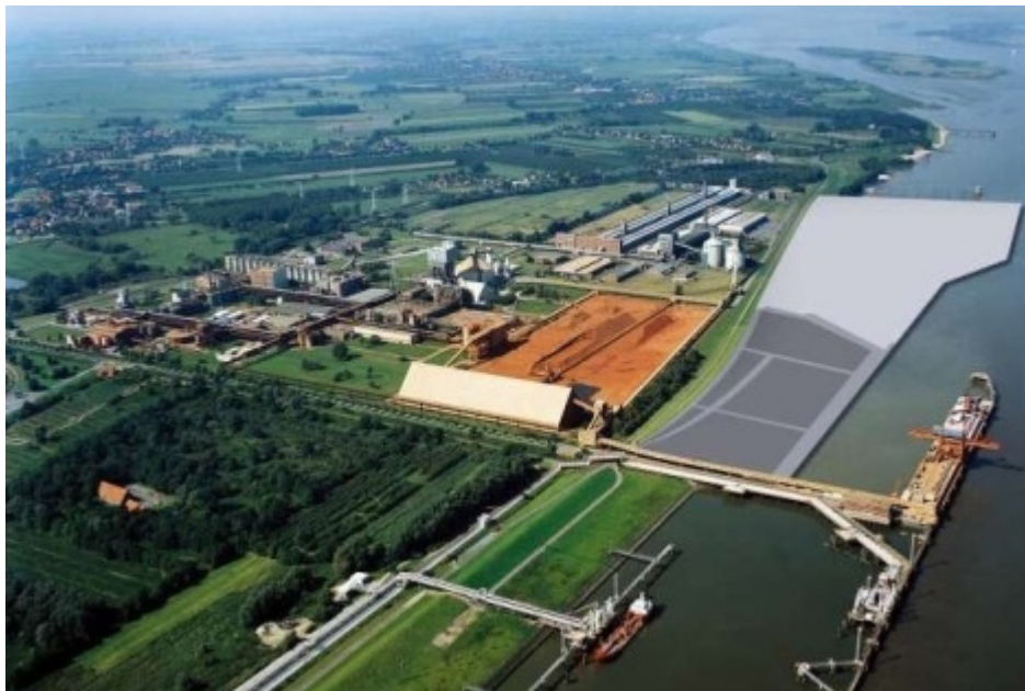
In Stade-Bützfleth entsteht auf der markierten Fläche bis 2009 der Buss-Hafen für Stück- und Massengut Foto: DW
